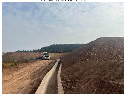
弃渣场截排水沟
