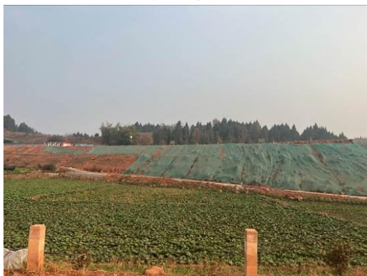
边坡临时覆盖
