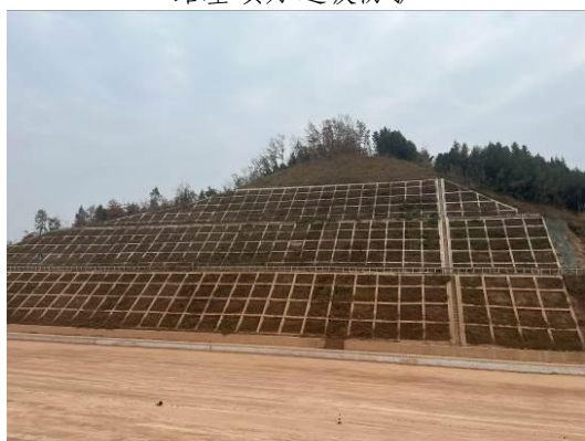
挖方边坡防护
