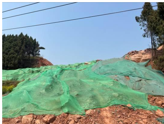
边坡临时覆盖
