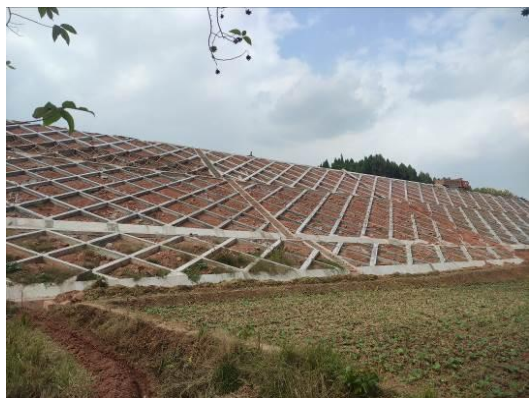
路基填方边坡防护
