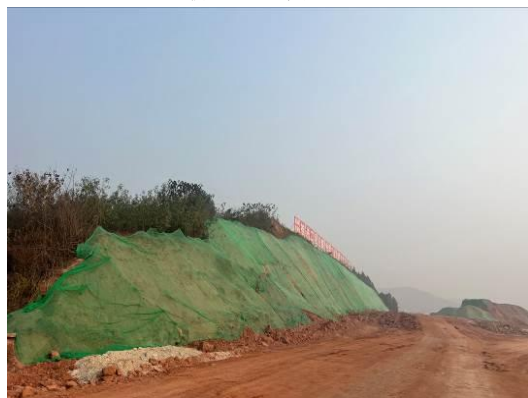
边坡临时覆盖
