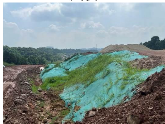
弃渣场临时排水沟
