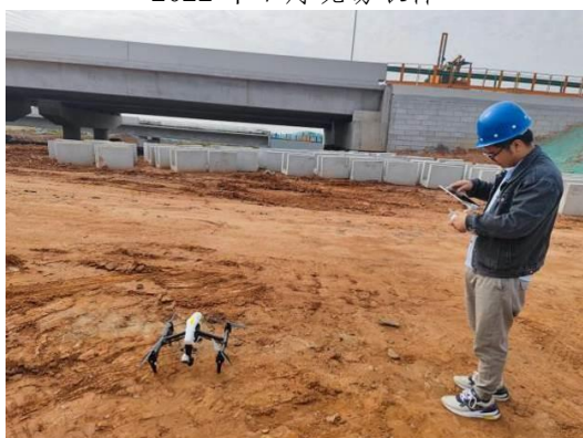
2022 年 9 月现场无人机监测
