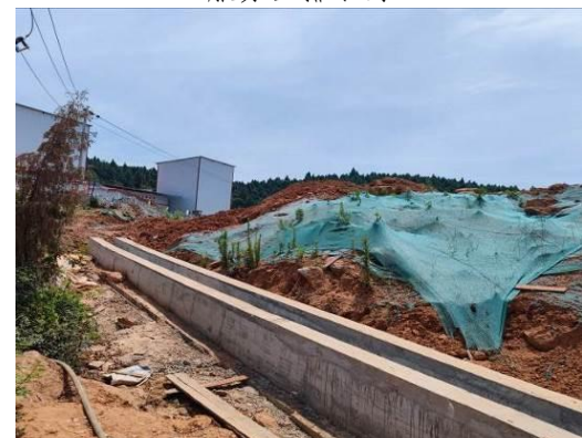
弃渣场区排水沟
