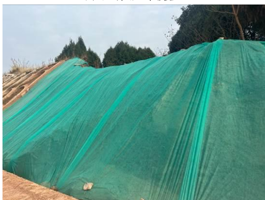
边坡临时覆盖
