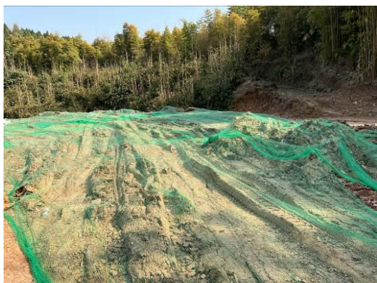
弃渣场临时覆盖
