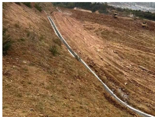
弃渣场截排水沟
