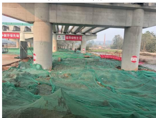
桥底临时覆盖
