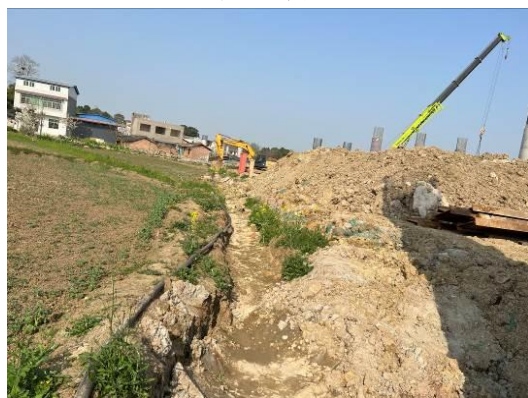
桥梁工程临时排水
