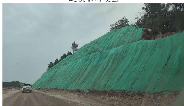
路基边坡临时覆盖
