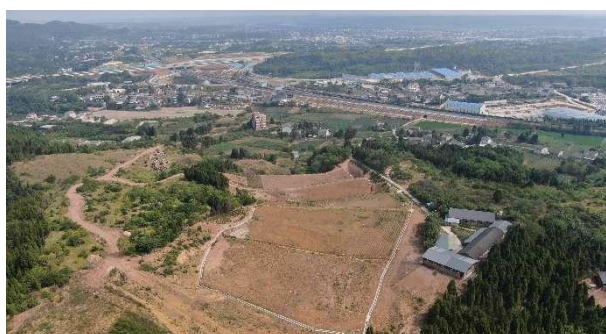
弃渣场周边截水沟
