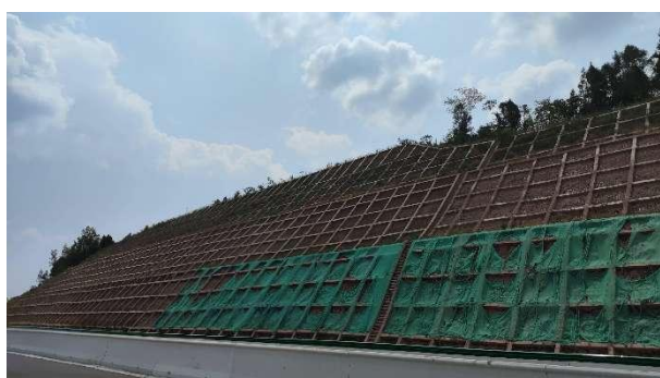
路基边坡护坡及截水沟
