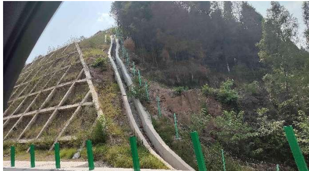
路基边坡截排水沟
