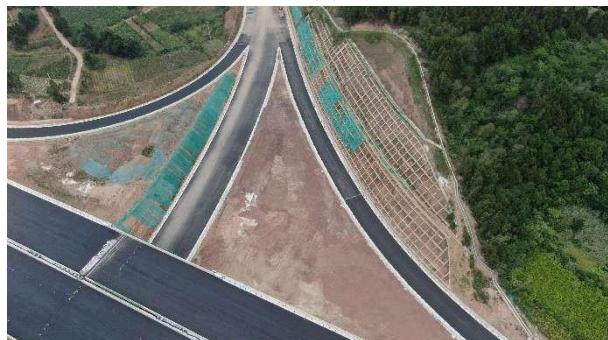
互通边坡防护
