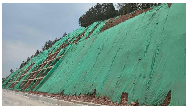
边坡临时覆盖
