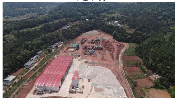
弃渣场周边截水沟
