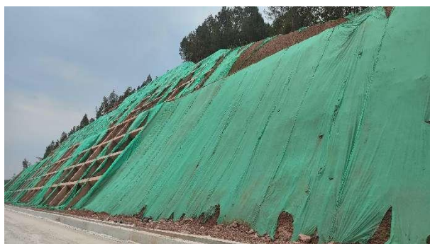
边坡临时覆盖
