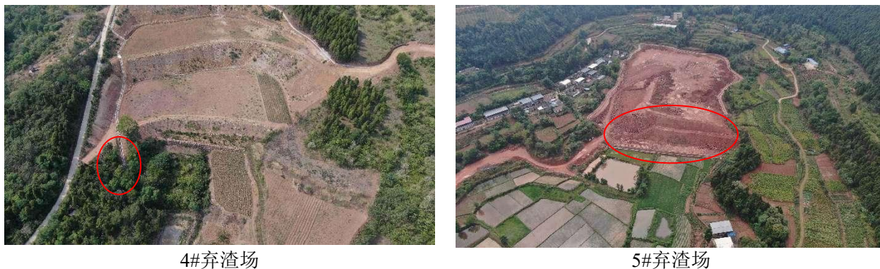
图 5-2 截排水沟出口无沉砂池弃渣场
