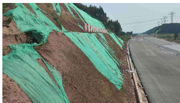
路基边坡绿化
