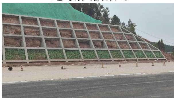
路基边坡防护及排水沟
