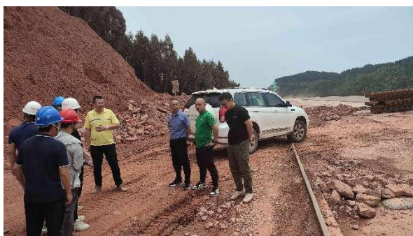
配合建设单位现场检查
