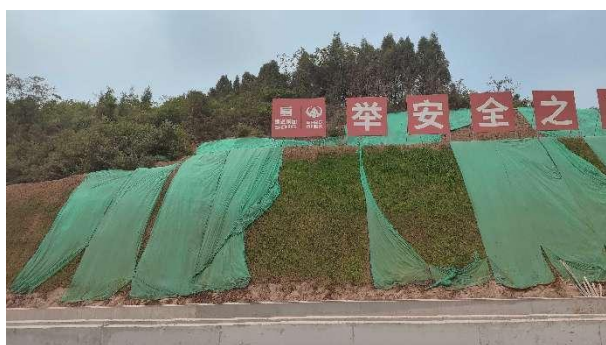
路基边坡绿化
