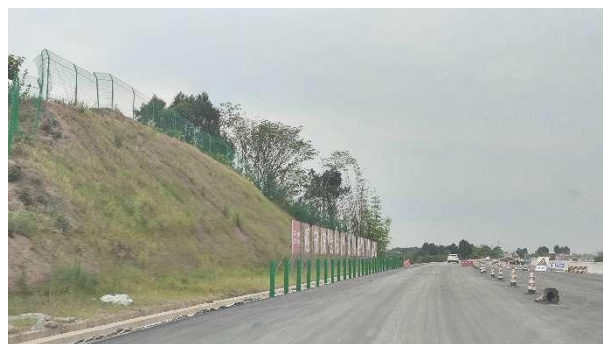
路基边坡绿化
