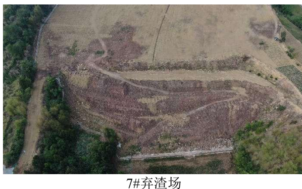
图 5-3 恢复措施滞后的弃渣场
