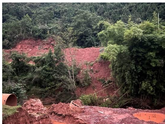
3-2 标段陈家湾大桥顺坡溜渣
