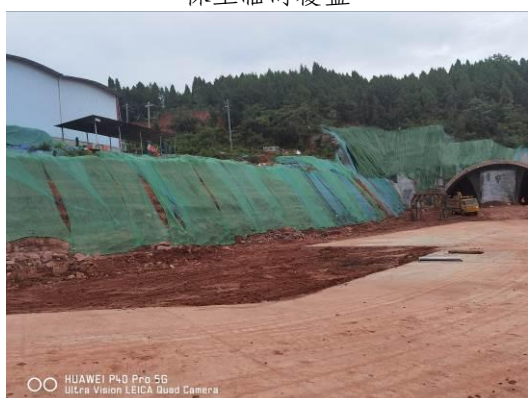
边坡临时覆盖
