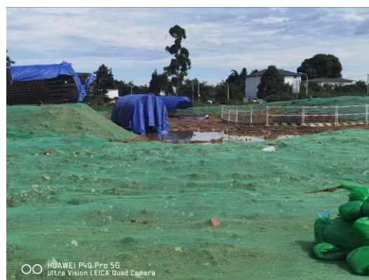
场内临时覆盖
