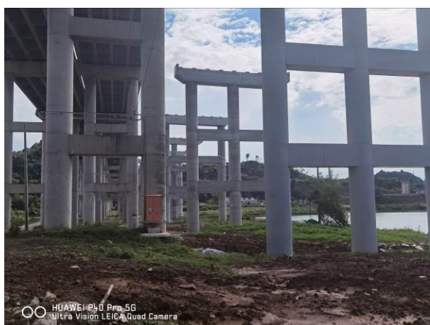
涪江大桥施工
