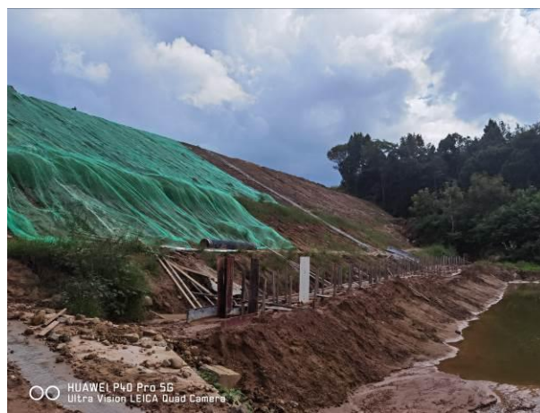
路基开挖边坡
