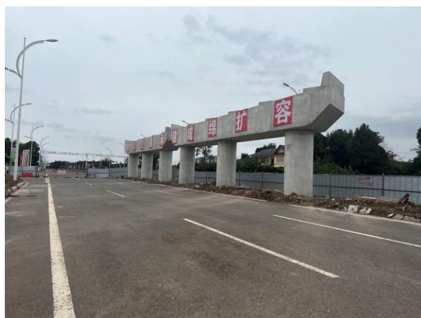
跨草堂村中桥施工
