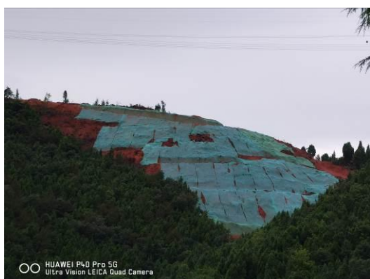
边坡临时覆盖
