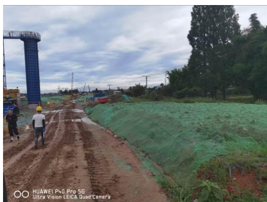
裸土临时覆盖
