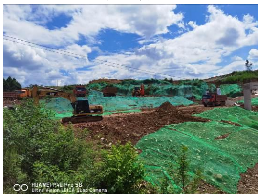
场内临时覆盖
