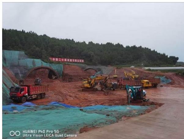
马鞍山隧道施工
