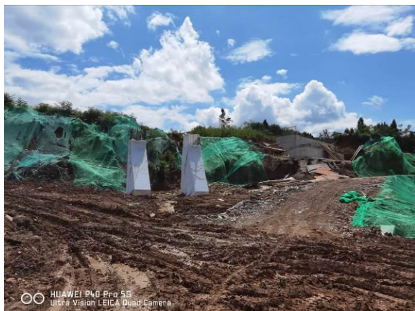
周家宴大桥施工
