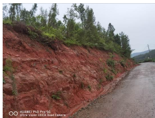
施工便道临时排水沟
