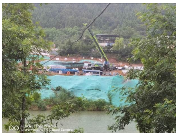
涪江大桥施工
