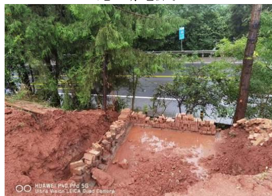
施工场地沉砂池
