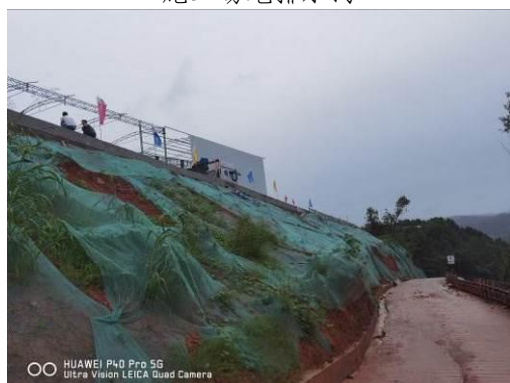
施工便道排水沟
