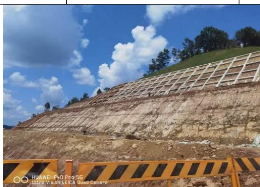
路基挖方边坡防护
