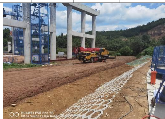
施工场地防护
