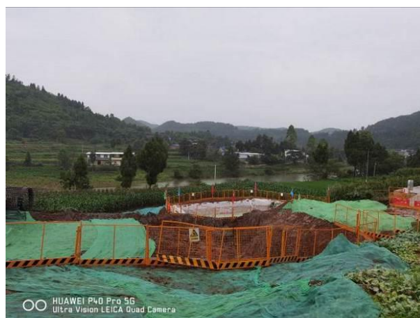
柏龙村特大桥施工
