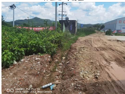
施工便道临时排水沟
