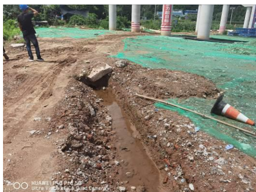
桥梁施工区临时排水沟
