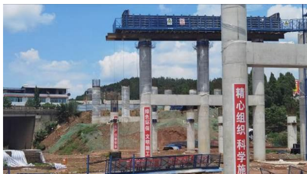
跨绵盐路大桥施工
