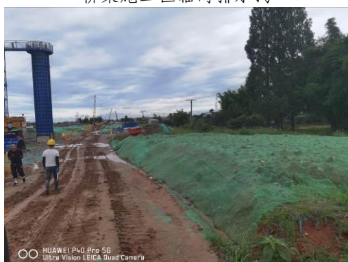
裸土临时覆盖
