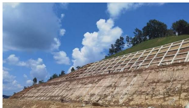
路基挖方边坡施工
