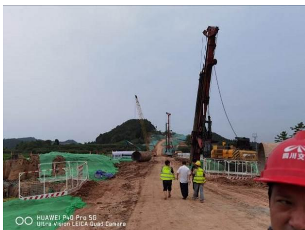
沙包咀大桥施工
