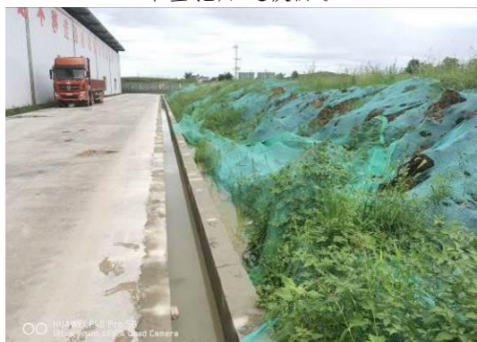
施工场地排水沟
