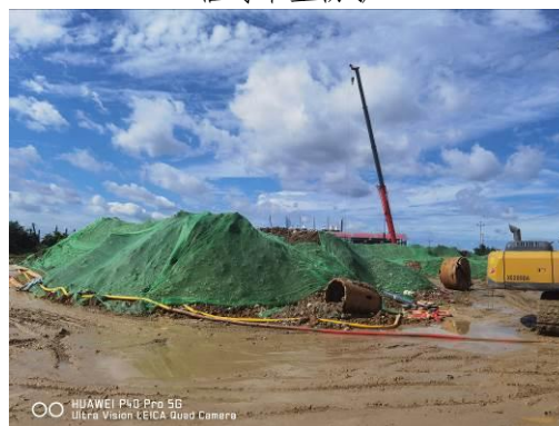
临时堆土覆盖
