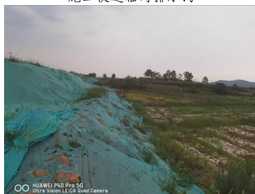
临时堆土防护
