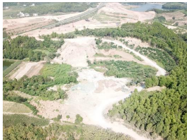
10 标段弃渣场无挡墙和临时排水措施
