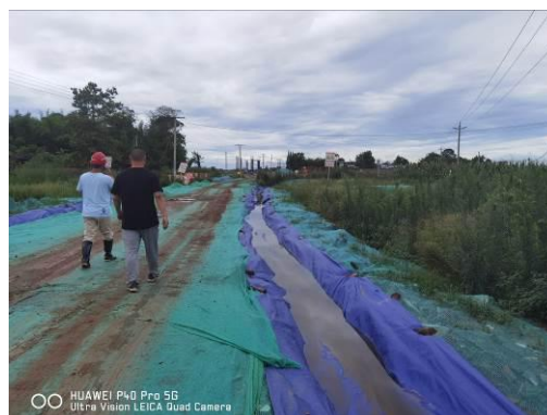
施工便道临时排水沟
