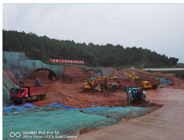
马鞍山隧道施工
